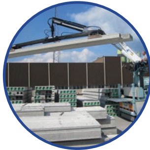
Handling van betonnen vloeren
